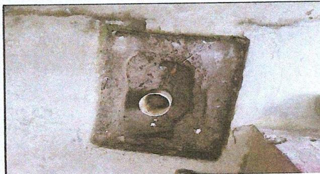
Foto 4: Instalación de llave de paso
